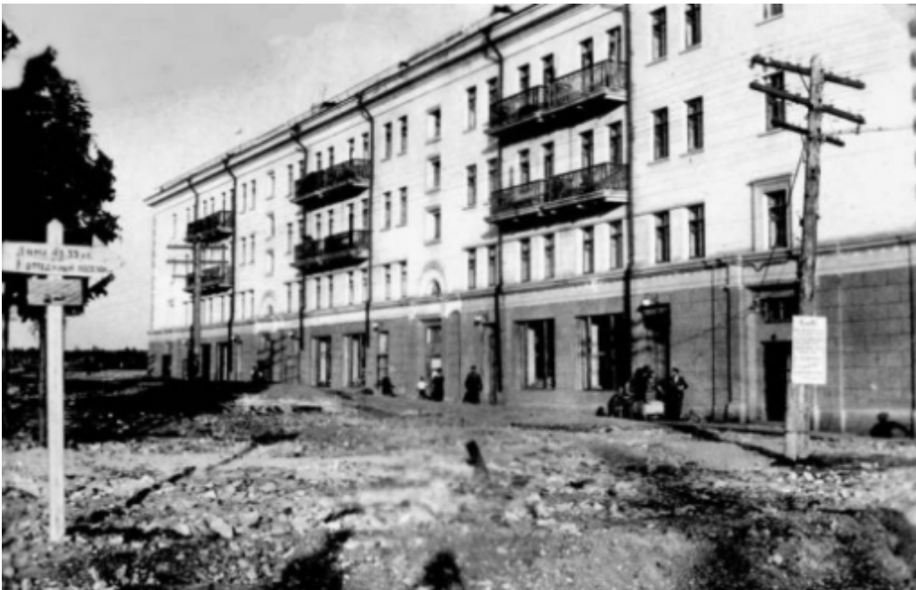
Рис. 6 – 63-х квартирный дом (фото 1958 года)
